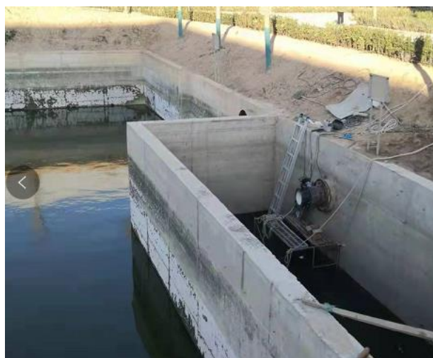
消防事故废水池和初期雨水池
